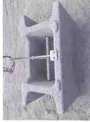
傾斜時吊り金具設置
