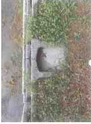
中詰コンクリート
