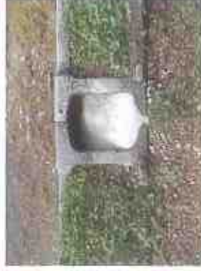
中詰コンクリート
